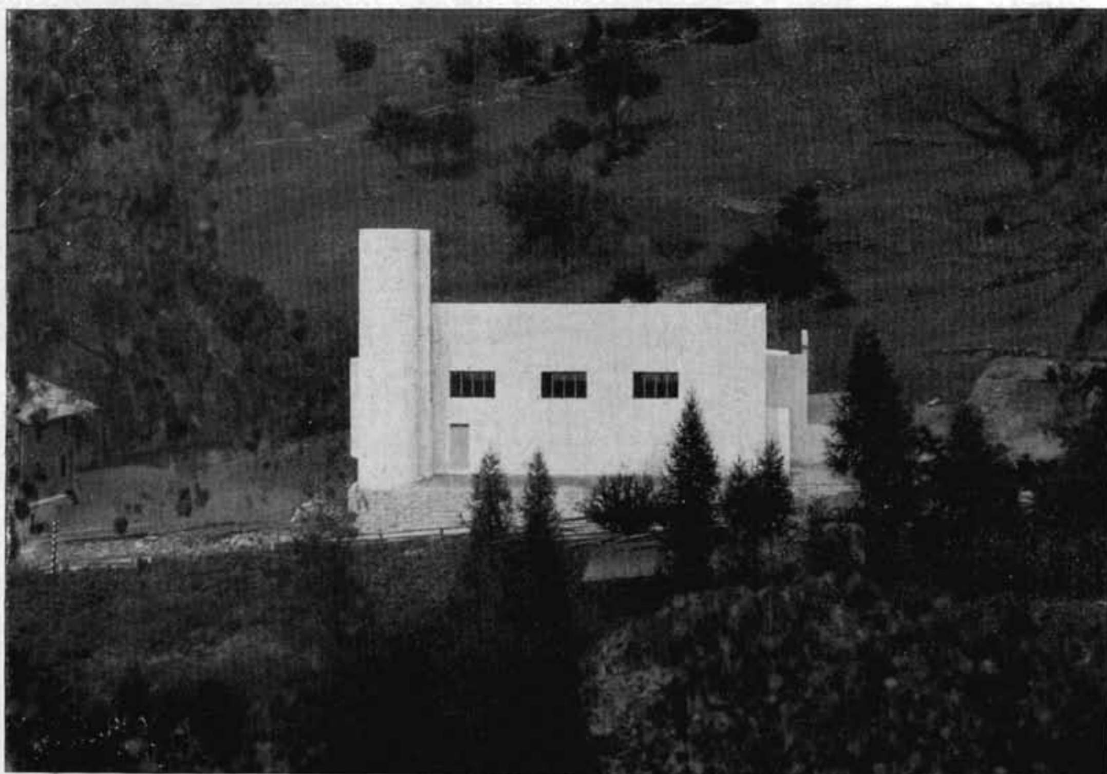
ARCH. ALBERTO SARTORIS / CHIESA CATTOLICA DI LOURTIER / VEDUTA GENERALE
